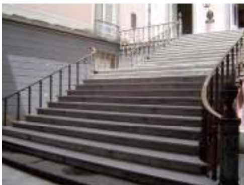
Figura 31 – Escadaria de mármore no pátio interno.
