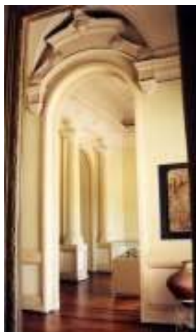
Figura 36 – Detalhes nas paredes e tetos próximos às Salas Históricas.
