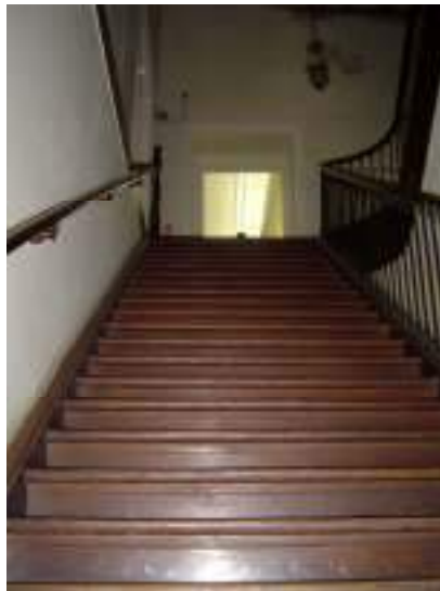
Figura 34 – Escadaria original de madeira vista a partir do primeiro piso em direção às Salas do Trono e do Corpo Diplomático.
